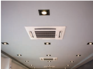
パッケージエアコン Packaged air conditioner
