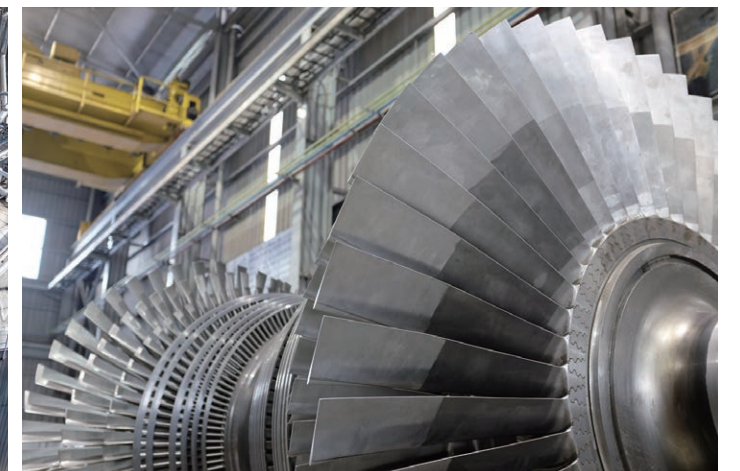
火力発電 Thermal power generation
